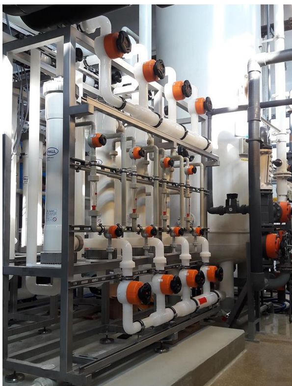
Filtrationseinheit für ultrareines Wasser mit PVDF-Material
